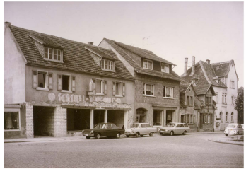
"Umbau der ehemaligen Drogerie Kürten in der Bahnhofstraße"
