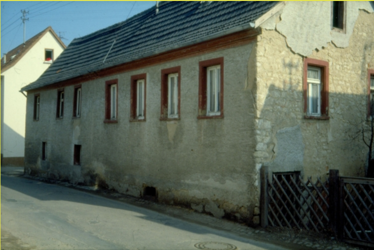
1. Die symmetrische Fensterreihe an der Westseite markiert die Rückseite des Betraumes, der die gesamte Breite des Hauses umfasste.
