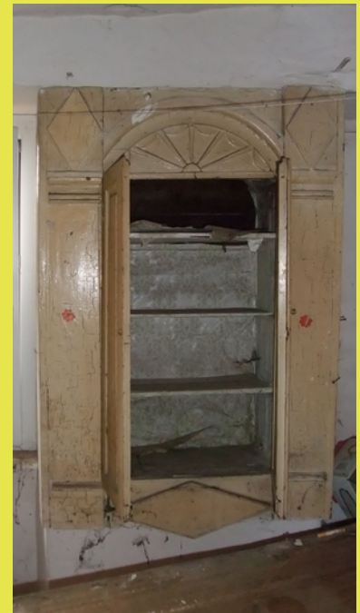
4. Die Ablagebrettchen wurden von späteren Nutzern angebracht.
