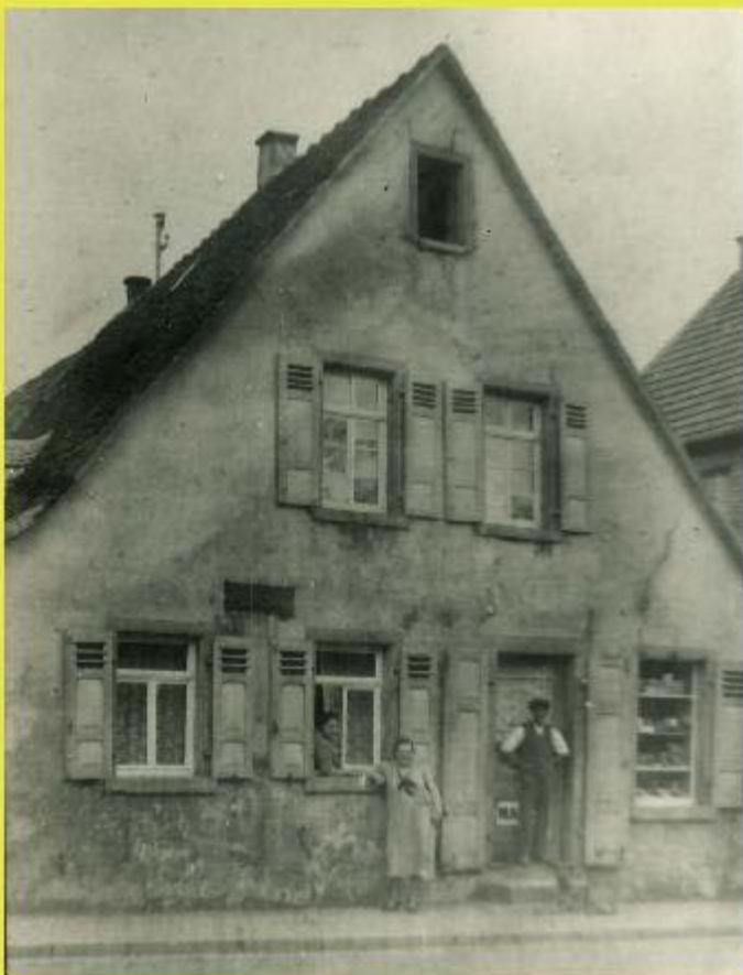
Die ursprüngliche Fassade mit dem zeitüblichen schlichten Ladenfenster und den großen Holzläden vor der Eingangstür.
